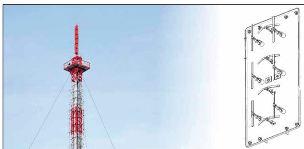
Bild 5. UHF-FeMBMS-Sendeantenne ISMANING und Blick ins Innere eines Antennenfeldes
